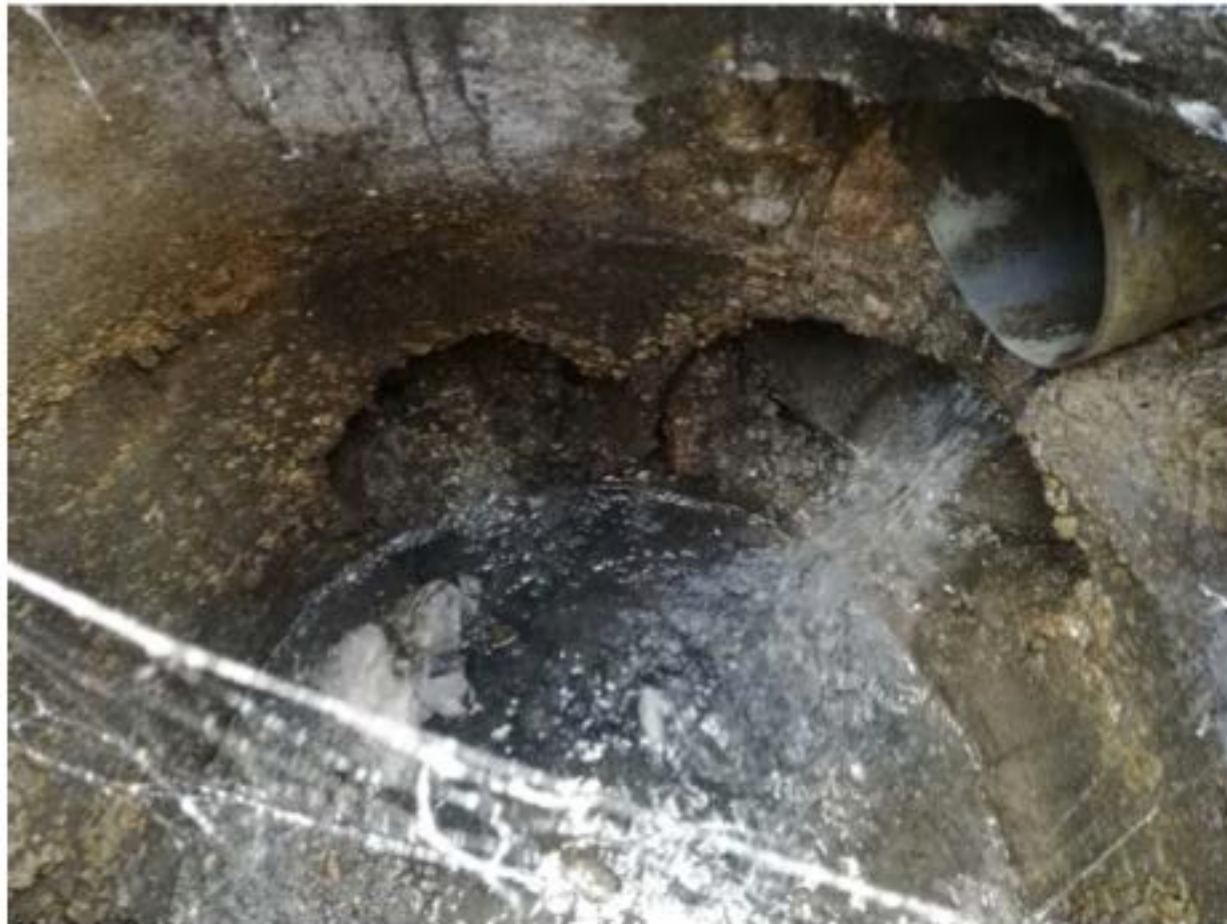
Estado actual de uno de los pozos a renovar
