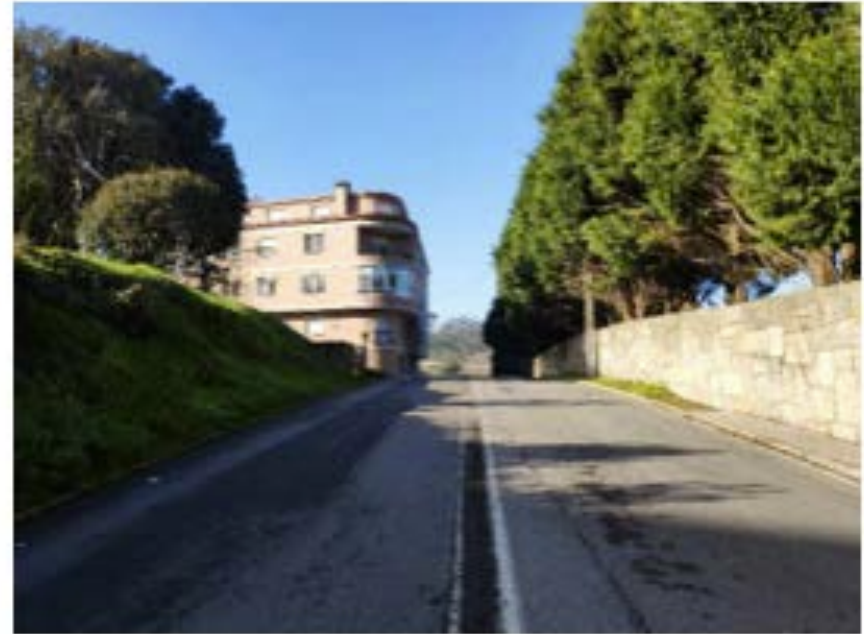
Estado actual de la Rúa Castilla la Mancha
