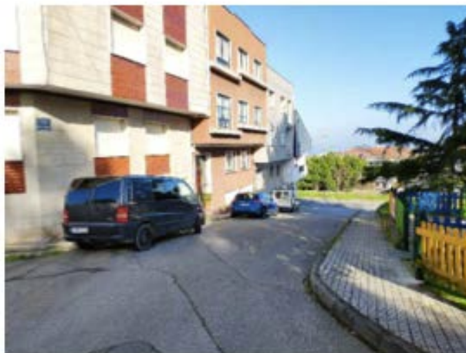
Estado actual de la Rúa Navarra
