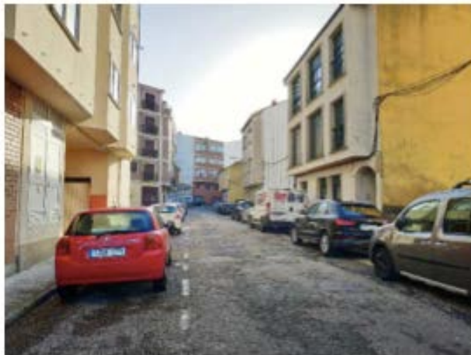
Estado actual de la Rúa Andalucía
