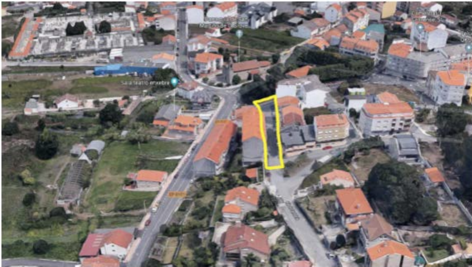
Situación de las obras en la Rúa de Cantabria
